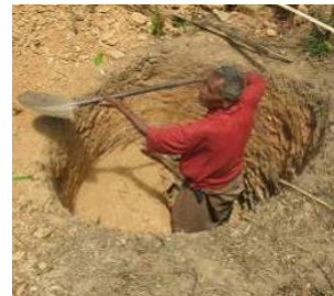
住民主導でのトイレ建設
